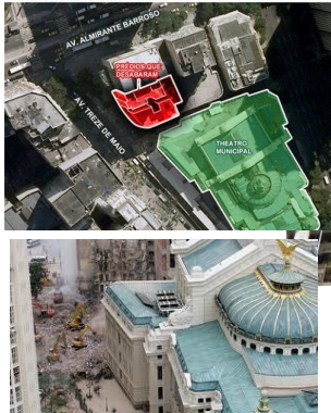
ÁREA AFETADA PELO DESABAMENTO
